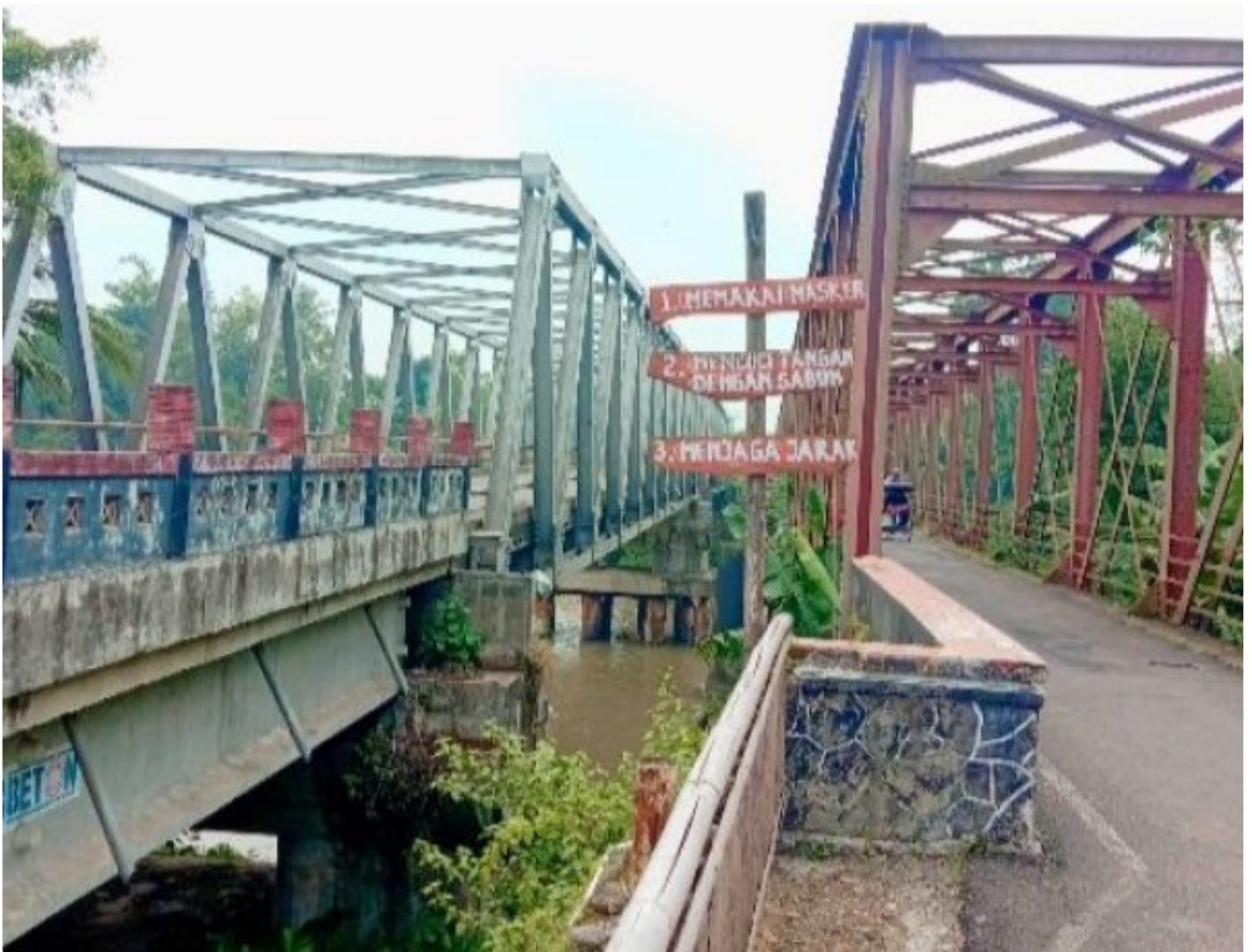
Dua Jembatan di Patikraja, Jembatan Merah Patikraja Dan Jembatan Baru
